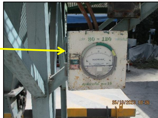
ภาพที่ 2.9 เครื่องมือวัดความดันตกคร่อมของ Bag Filter
