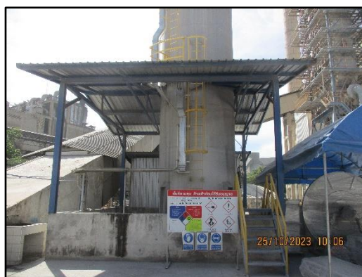
ภาพที่ 2.7 การติดตั้งระบบฉีดแอมโมเนียอัตโนมัติ (Ammonia spray system) และการติดตั้งระบบป้องกันและควบคุมความดันของถังแอมโมเนีย
