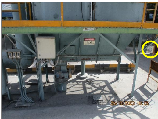
ภาพที่ 2.9 เครื่องมือวัดความดันตกคร่อมของ Bag Filter
