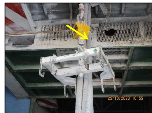
ภาพที่ 2.11 ท่อลมดูดฝุ่นขณะจ่ายปูนซีเมนต์ใส่รถเต๋า
