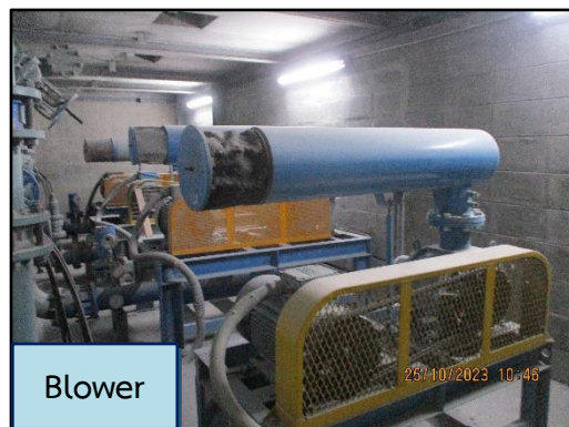
ภาพที่ 2.20 ห้องเก็บเสียงของ Blower และ Pfizer สำหรับป้องกันเสียงจากกระบวนการผลิต
